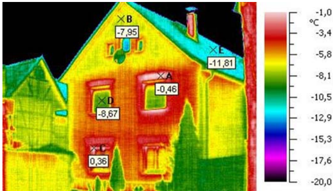
Wärmebild einer ungedämmten Außenwand von Lutz Weidner auf wikipedia.de
